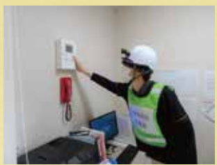
火災報知器作動
