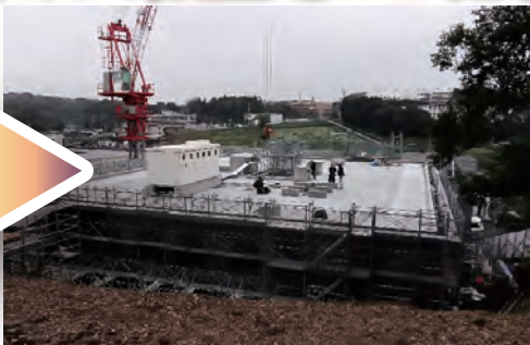
屋上まで完成 外壁のタイルも貼られています
