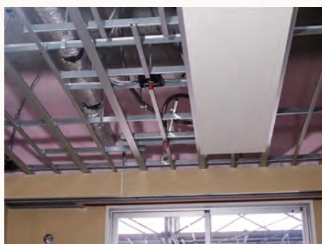
まだ天井も配管と鉄骨がむき出し
